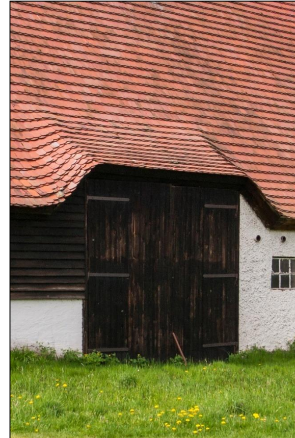
OS_WW5c Budynek gospodarczy, widoczny detal architektoniczny (charakterystyczne ukształtowanie dachu nad wejściem do stodoły „wale oko”)
