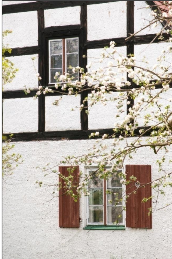
OS_WW5a Budynek mieszkalny, widoczny detal konstrukcyjny i materiał budowlany (mur pruski). Zachowane oryginalne okna z okiennicami.
