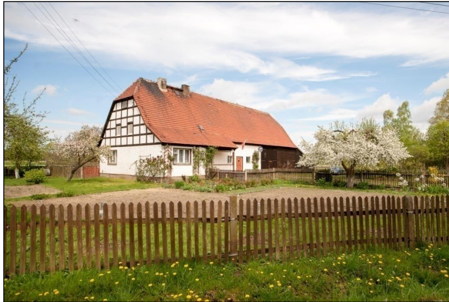
OS_WP5a Zabudowa zagrodowa widoczna od strony mieszkalnej
