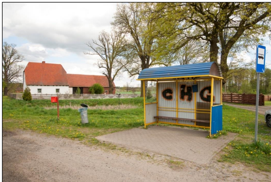
OS_IPB3a Przystanek komunikacji autobusowej
