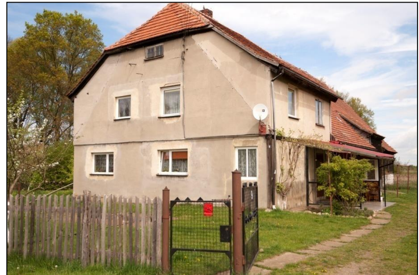
OS_WN3b Prywatny dom. Widoczne przekształcenia, zmianie uległa kubatura budynku, kształt dachu, stolarka okienna.
